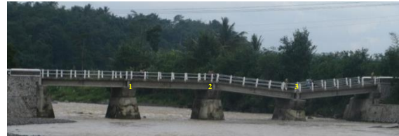
Gambar 1. Jembatan Trinil, Magelang, Jawa Tengah
