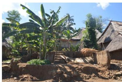
pondasi *Bale* terbuat dari bahan bahan campuran batu dan tanah yang dipadatkan. konstruksi pondasi *Bale* berbentuk tingkat. Pondasi yang ditinggikan ini berkaitan dengan adanya cerita yang beredar dikalangan masyarakat Sasak Limbungan secara turun-temurun, sehingga menjadi semacam keyakinan
