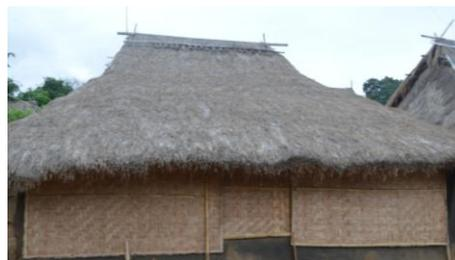
Dinding *Bale* menggunakan konstruksi bambu. Dinding bagian depan dan dinding belakang menggunakan konstruksi anyaman bambu. Tiang-tiang *Bale* digunakan sebagai tempat berpegangnya dinding, dan menggunakan belahan bambu sebagai bantalan. Untuk mengikat dinding dengan tiang masyarakat Limbungan menggunakan rotan sebagai pengikat.
