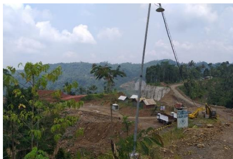
Gambar 1. Area Pembangunan Bendungan Bener Sumber: Peneliti, 2023
