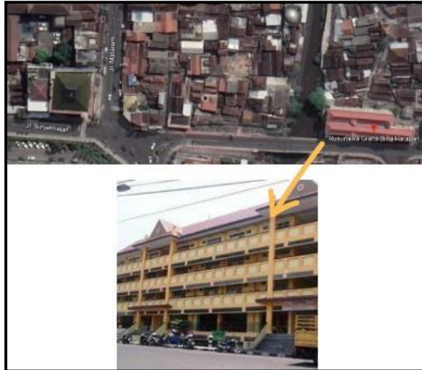
Gambar 2. Lokasi dan gedung Rusunawa Grha Bina Harapan Sumber: Aplikasi Google Earth, 2022
